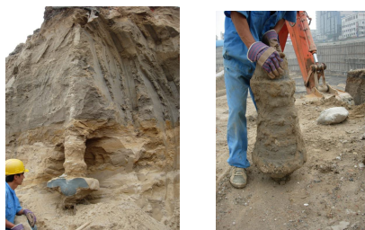
图 2 (a) 砂层扩孔效果 (b) 粉质粘土扩孔效果 Fig.2 Effect photos of hole expansion in sand layer (a) and silt clay (b)
